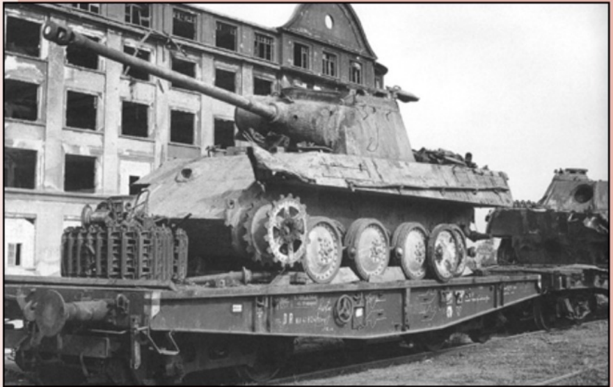
NPF blz.200. De vernietigde M.A.N. fabriek met beschadigde Panther tanks die wachten op herstel. De tank staat op een Ssyms 50 ton, open platte spoorwagon met twee drie-assige draaistellen.
