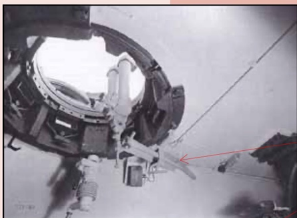
◀ NPF blz.181. Panther Ausf. G interieur. Commandantkoepel met schaartelescoop (Scherenfernrohr SF14) met verstelbare interne rail.
